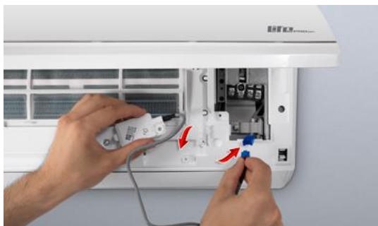
3. korak: povežite kabel Wi-Fi modula u priključak
