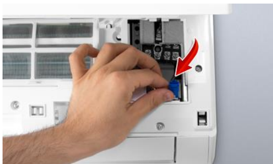
2. korak: pronađite kabel sa plavim priključkom
